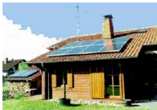
"Tetto fotovoltaico" collegato alla rete BT
